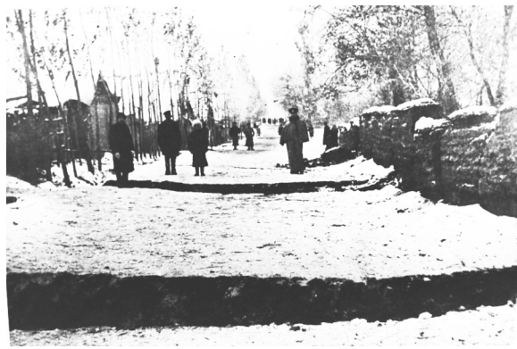
Последствия землетрясения в Верном.
